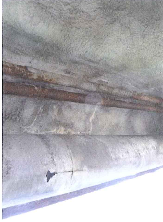
7 detail podhledu chodníkové konzoly na výtoku.JPG
