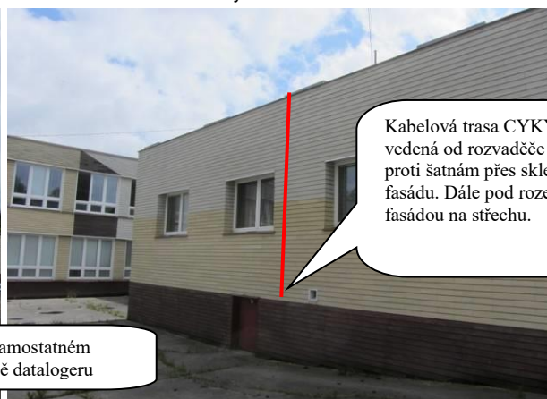
Obr. 4 ZŠ U Nemocnice – kabelová trasa napájecího kabelu
