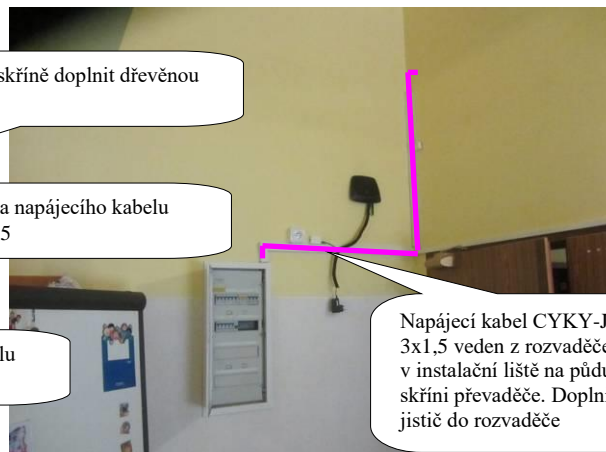
Obr. 2 Chodba – kabelová trasa, napájení skříně
