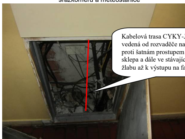
Obr. 5 Chodba ZŠ – kabelová trasa
